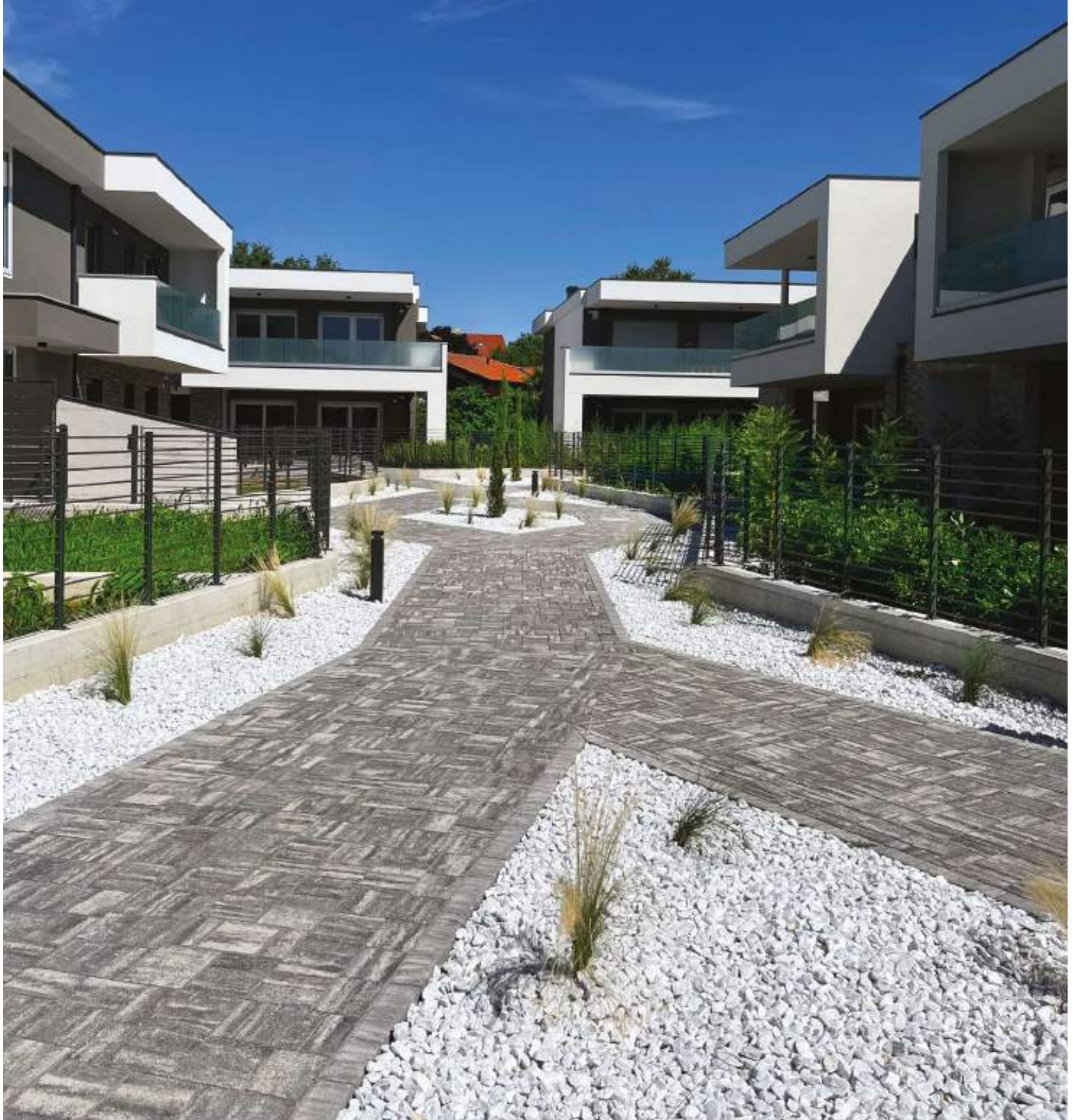
CASSIA DRENOPAV® - SABBIA DI SATURNO
