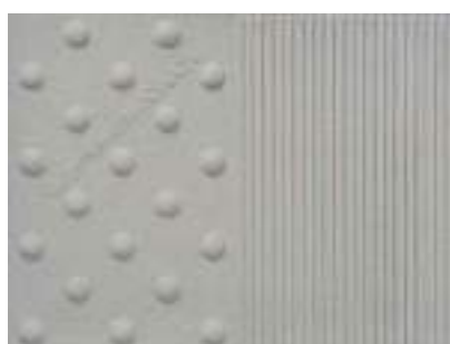
PERICOLO VALICABILE Passable danger
