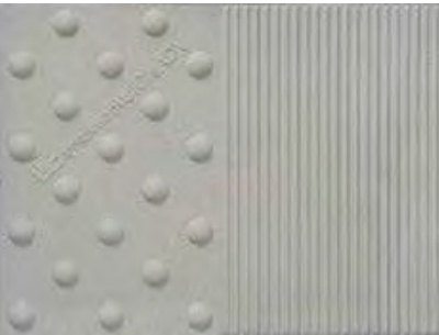
PERICOLO VALICABILE Passable danger
